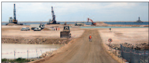
Capobianco: il cantiere LNG in piena attività nell'estate 2006
