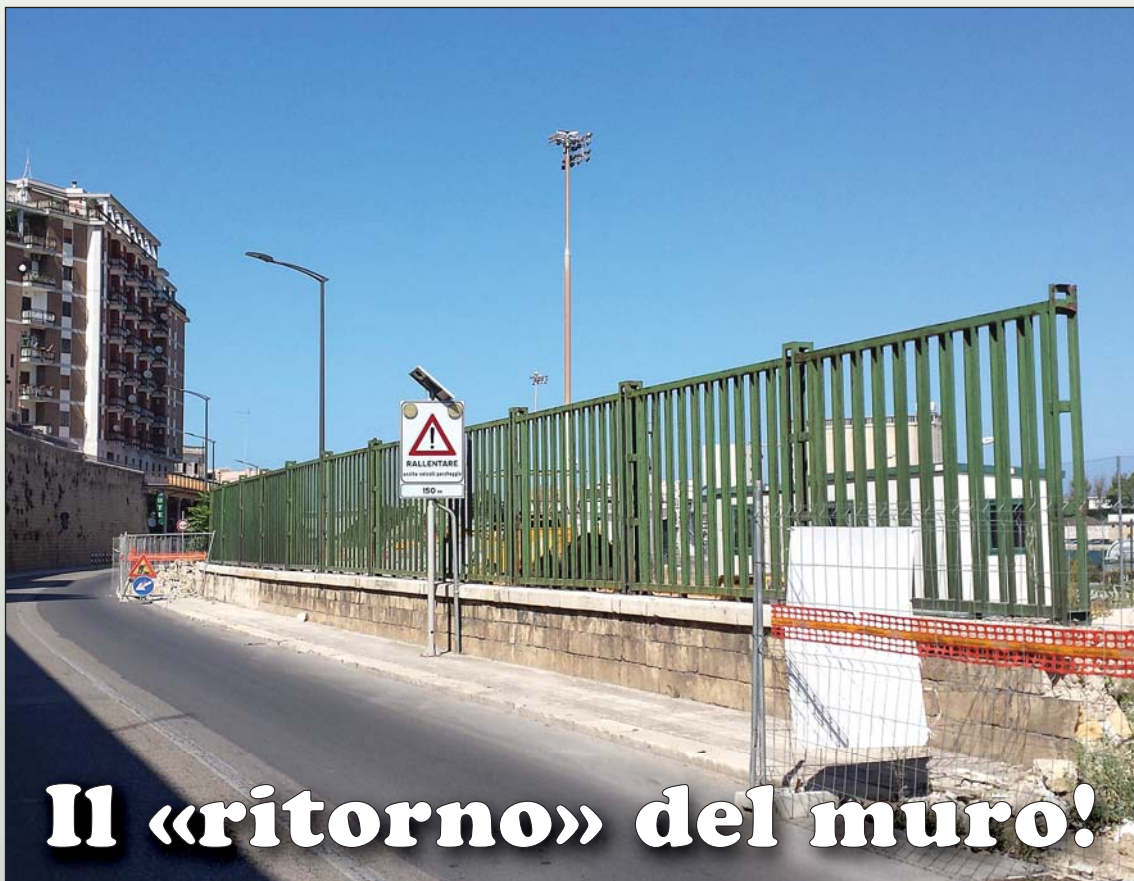
L'ultimo pezzo del vecchio muro di via del Mare (foto scattata il 27 agosto 2015)
