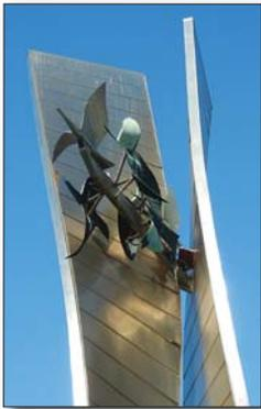
schio di staccarsi sotto l'azione degli agenti atmosferici. L'intervento consiste nel fissare, con nuovi rivetti in alluminio, tutte le fasce di rivestimento del monumento, per eliminare il pericolo immediato e assicurare stabilità alla scultura.
